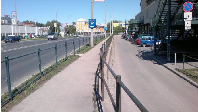
64. kép: 2.1 szakasz, a Palotai út (belváros felőli oldal) Alba Plaza melletti egyirányú szervízúton a kerékpárosok irányhelyesen haladhatnak, kerékpáros nyom felfestése javasolt
