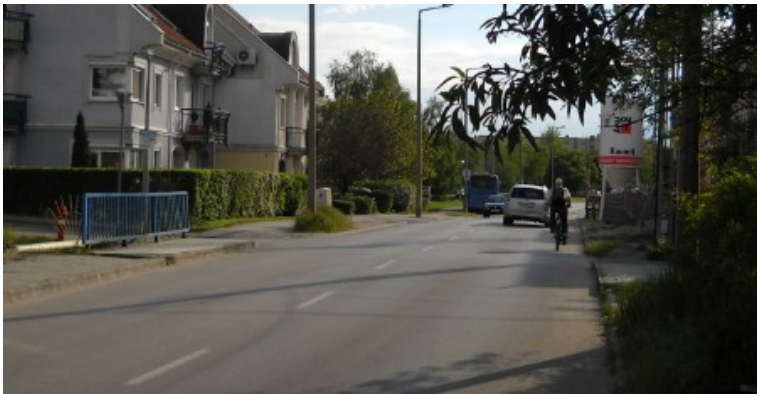
61. kép: Bregyó közti Malom-csatorna híd
