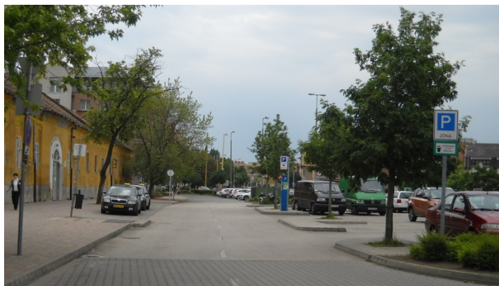
66. kép: Piac tér belváros felőli oldalán a szervízút kerékpározásra való kijelölése
