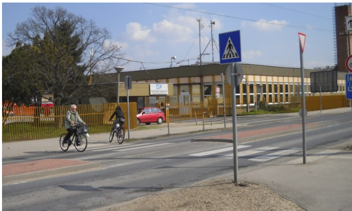
29. kép: A Palotai úti gyalogos-kerékpáros átvezetés (a Gaja híd előtt) Palotai úti osztatlan gyalog-és kerékpárút a Szeder köz – Keresztöltés között (1.1 szakasz)
