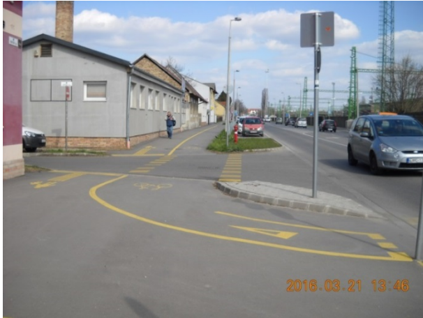
57. kép: Mártírok útja közös gyalog- és kerékpárút szakasza a Fűtőház utcánál
