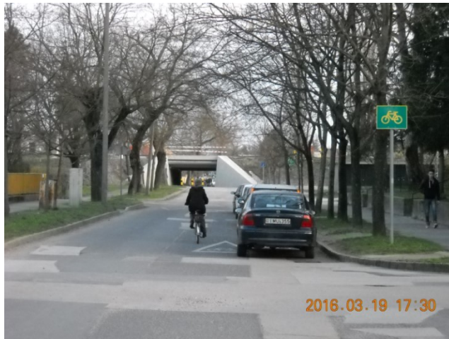
40. kép: A Hosszúsétatér kisforgalmú útján kijelölt kerékpárút a Horvát I. utcától a Csíkvári útig (5. szakasz)
