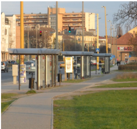
35. kép: Palotai úti önálló kerékpárút a Piac térnél (2.2 szakasz)
