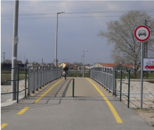
11. kép: Palotai úti gyalogos-kerékpáros Gaja-patak híd
